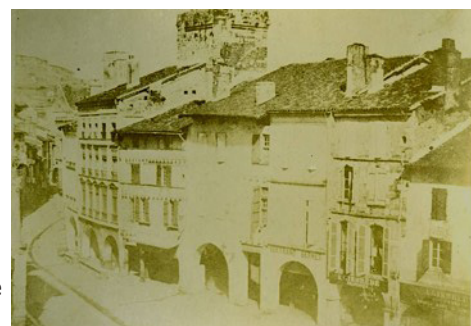
j. Cornières et tour de Cailhau, AD 47, 5 Fi 56
