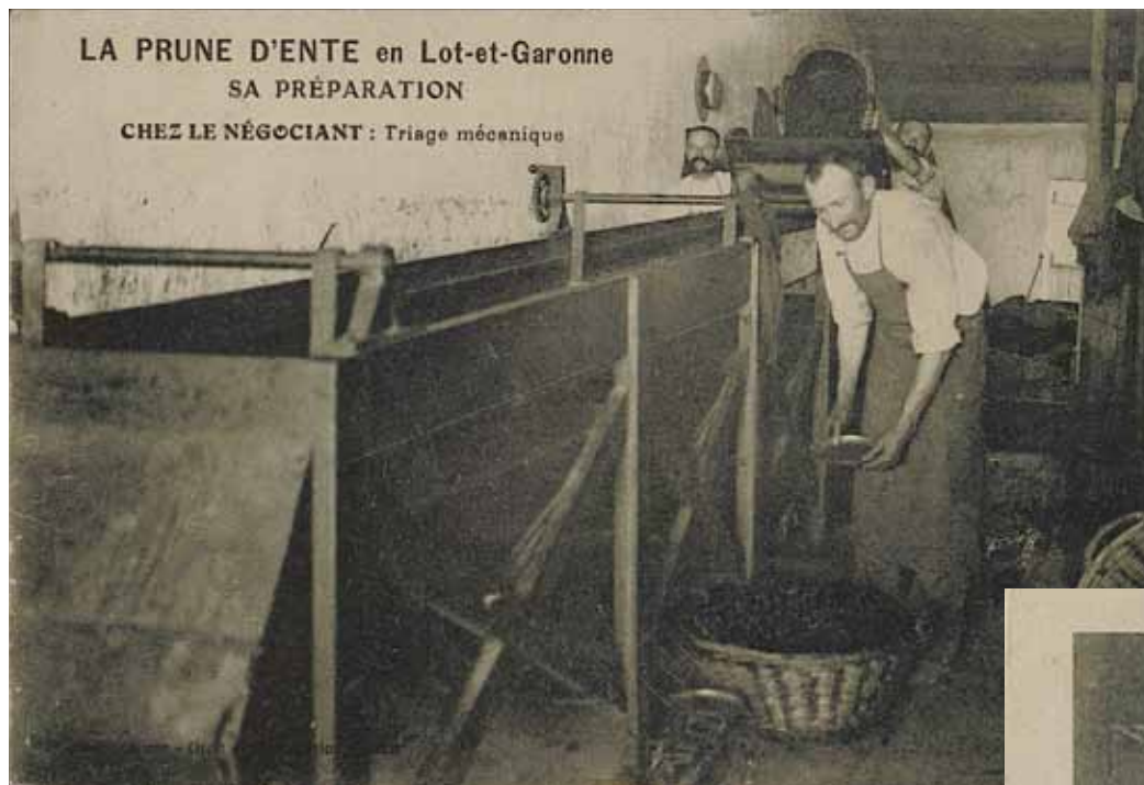
La prune d'ente en Lot-et-Garonne, sa préparation : triage mécanique chez le négociant. Carte postale ancienne, sans lieu ni date. Arch. dép. de Lot-et-Garonne, 7 Fi 349/33
