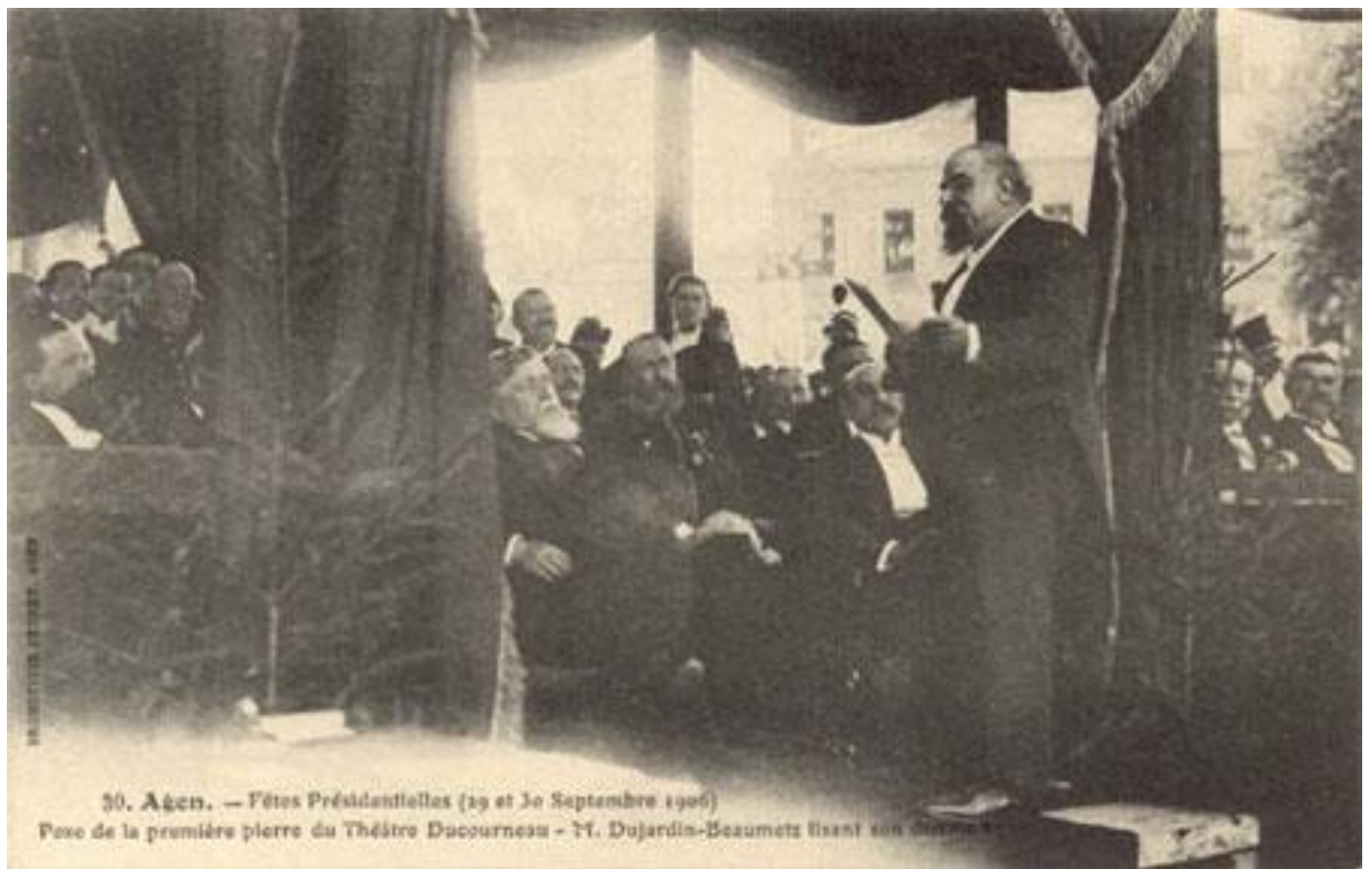
Visite du président Fallières à Agen - Pose de la première pierre du théâtre Ducourneau. M. Dujardin-Beaumets (127 J 682)
